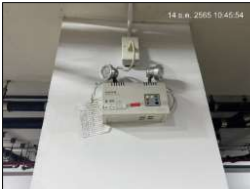
ภาพที่ 16 ไฟฟ้าสำรองฉุกเฉิน
