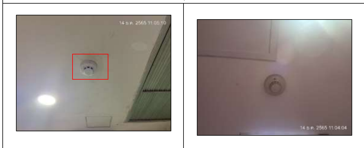
ภาพที่ 20 เครื่องตรวจจับความร้อน
