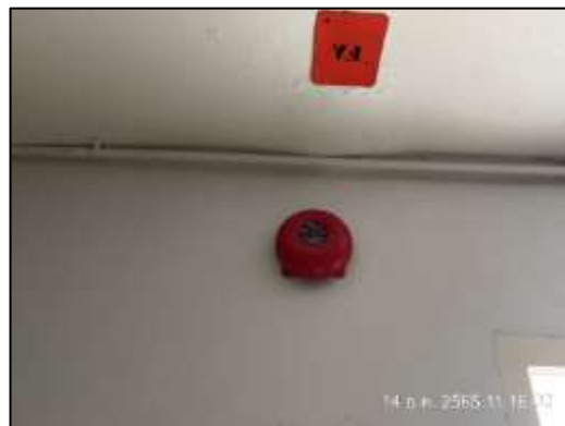
ภาพที่ 15 กริ่งสัญญาณเตือนภัย
