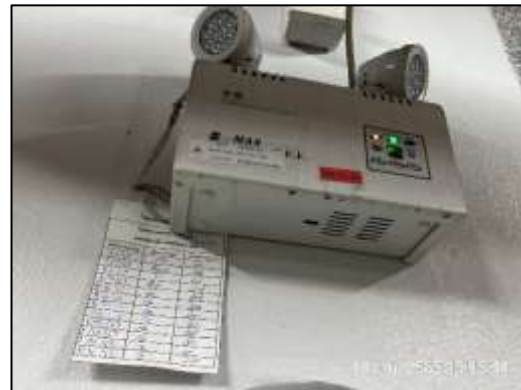
ภาพที่ 16 ไฟฟ้าสำรองฉุกเฉิน
